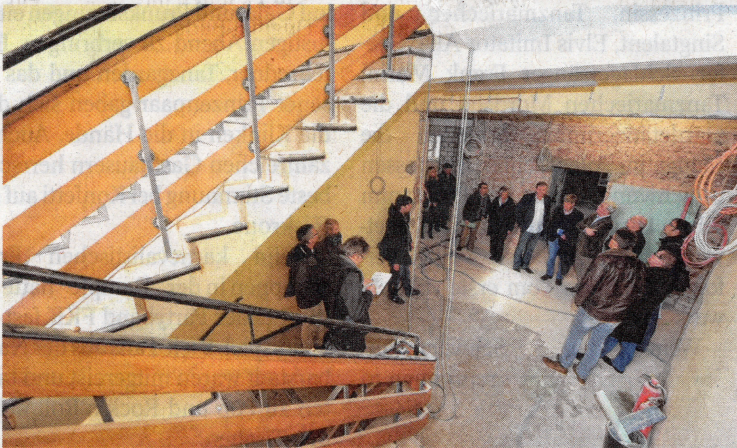
Baustellen-Begehung mit dem Oberbürgermeister: In Karnap teilen sich bald Kita und Grundschule ein Gebäude – ein Modellprojekt.
